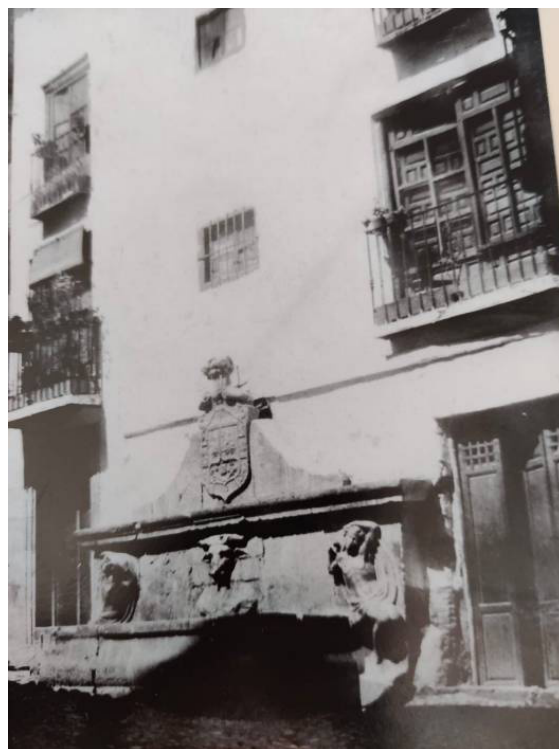
Ubicación del Pilar del Toro entre dos casas, tras la construcción de la Gran Vía
